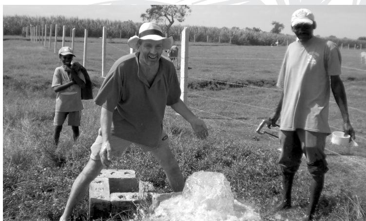
Reparierte Quelfassung: sauberes Trinkwasser für die Region
