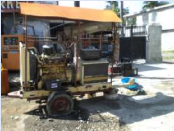
Es fehlen Kompressoren
