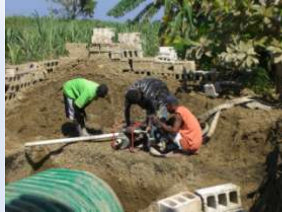
Es fehlen Schläuche
