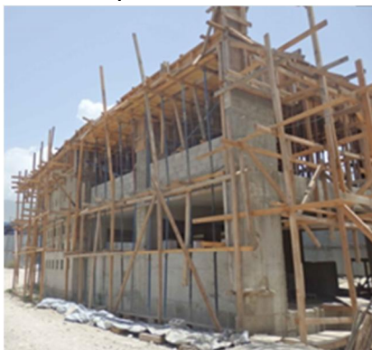
Das Schulhaus im Bau.
